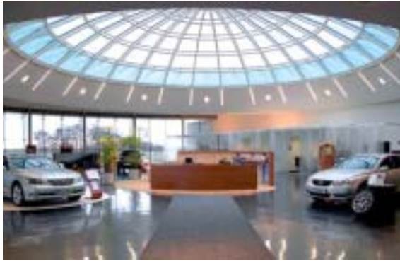
Der vom Salzburger Architekten und Adolf-Loos-Preisträger Dr. Volkmar Burgstaller geplante Rundbau wurde nach dreizehnmönatiger Bauzeit fertiggestellt und bietet Platz für bis zu fünfzehn Ausstellungsfahrzeuge.
